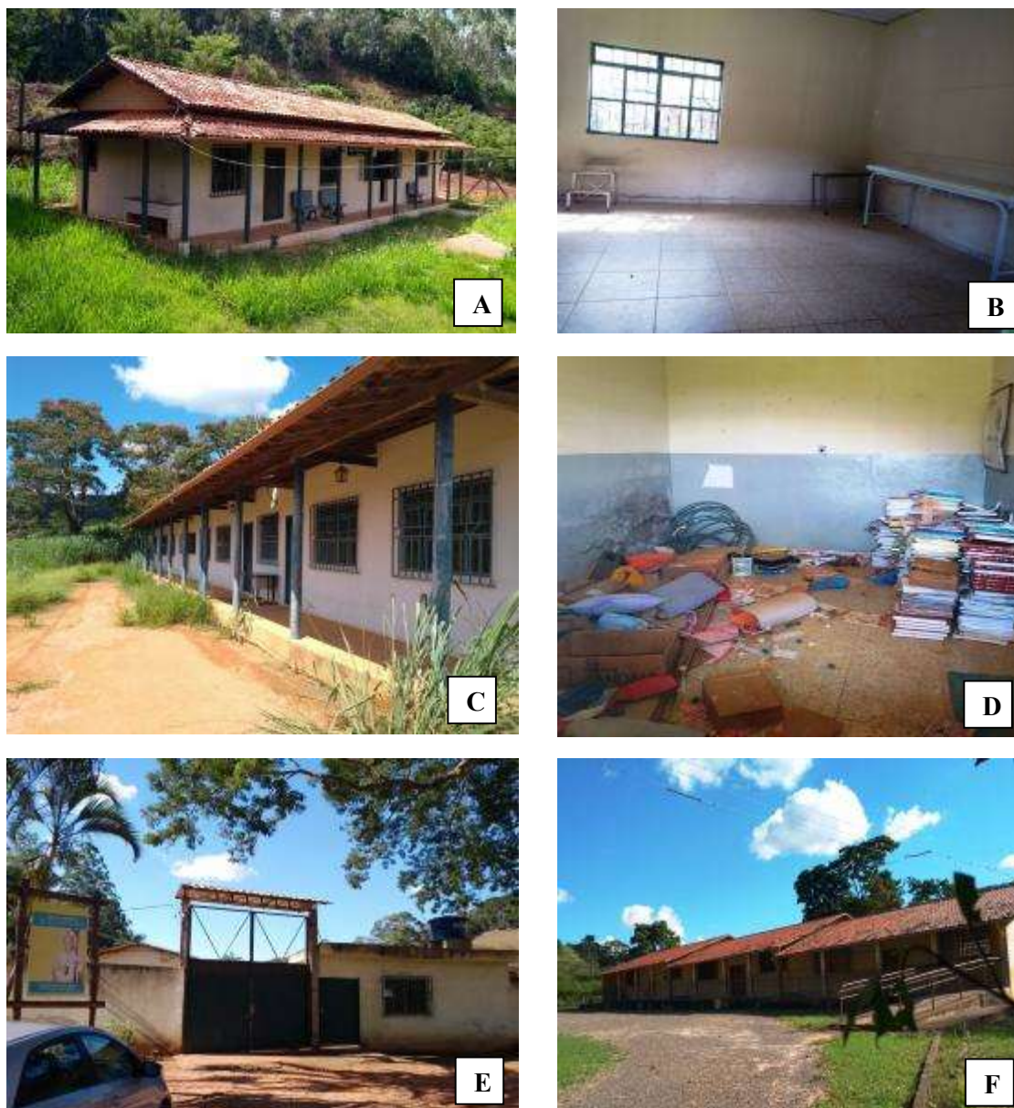
Figura 4 – A) Fachada da Escola Municipal Santo Antônio, comunidade Pau de Cedro; B) Interior da Escola Municipal Santo Antônio (A) transformada em Unidade Básica de Saúde – UBS; C) Fachada da Escola Municipal Arlindo de Paula Gonçalves, comunidade Córrego do São João; D) Interior da Escola Municipal Arlindo de Paula Gonçalves, com material didático espalhado pelo chão; E) Fachada da Escola Municipal Monsenhor Joaquim Dimas Guimarães, comunidade Piúna, transformada em casa de recuperação de dependentes químicos; F) Fachada da Escola Municipal Prof. Paulo Mário Del Giudice, comunidade da Colônia, atualmente escola polo das comunidades Pau de Cedro, Córrego do São João e Piúna. Fonte: Arquivo da pesquisa (2019).
