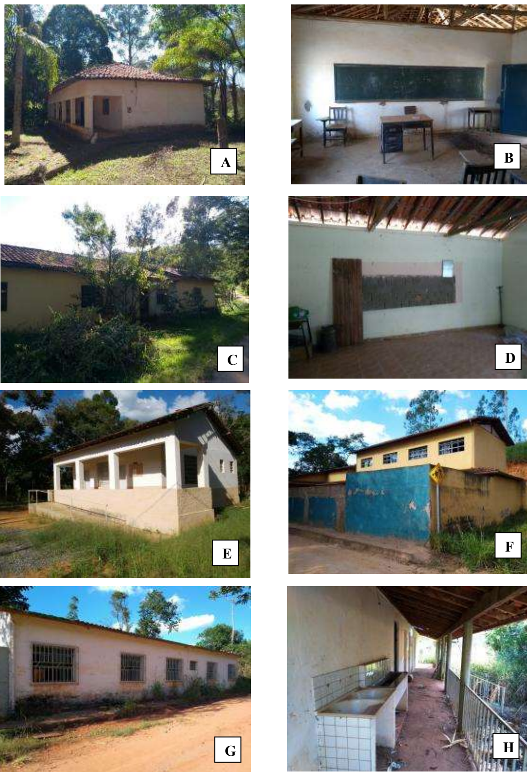
Figura 5 – A) Fachada da Escola Estadual José de Paula Lana, comunidade Juquinha de Paula; B) Interior da Escola Estadual José de Paula Lana (A) desativada; C) Fachada da Escola Municipal Maria Eugênia de Freitas, comunidade do Paiol; D) Interior da Escola Municipal Maria Eugênia de Freitas, desativada; E) Fachada da Escola Municipal Nossa Senhora do Carmo, comunidade Silêncio, transformada em UBS; F) Fachada da Escola Municipal José Lopes Valente Sobrinho, comunidade da Violeira, atualmente escola polo das comunidades Silêncio e Córrego Fundo; G) Fachada da Escola Municipal Prof. Jacyra do Vale Rodrigues, comunidade Córrego Fundo; H) Fundos da Escola Municipal Prof. Jacyra do Vale Rodrigues, comunidade Córrego Fundo. Fonte: Arquivo da pesquisa (2019).
